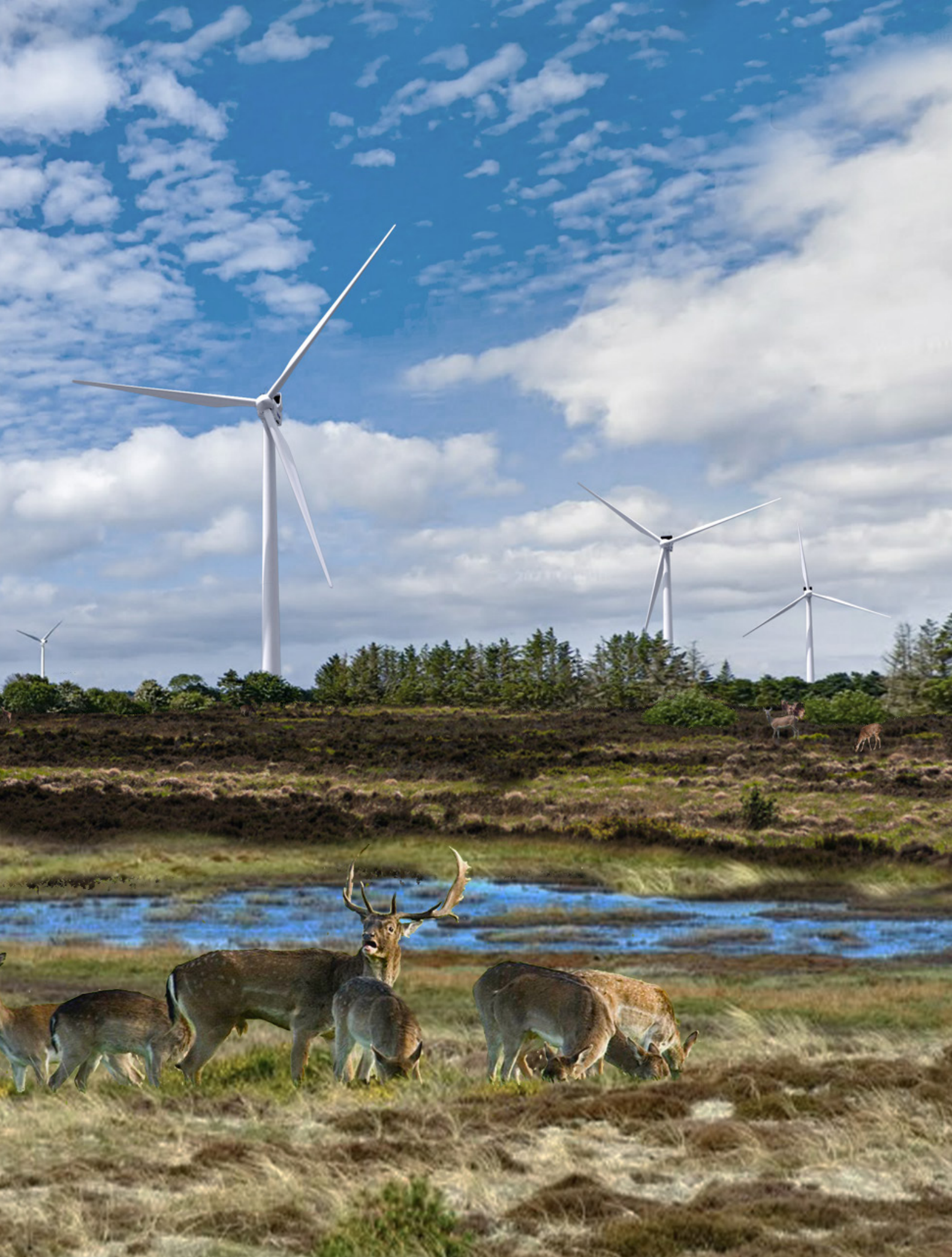
Visualisering af 200 meter høje vindmøller med en rotordiameter på 162 meter, set fra Ballesigvej mod syd
